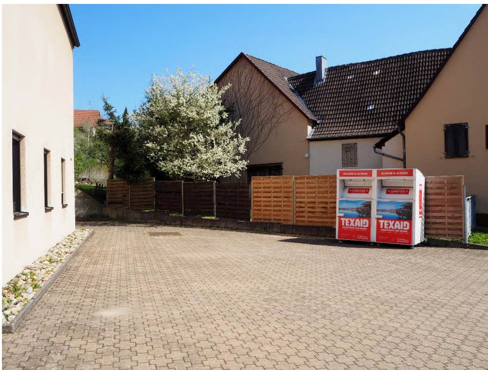
Bereich Hauptstraße Ortskern / Beispiel „gesichtsloser“ Hofbereich mit hohem Versiegelungsgrad
